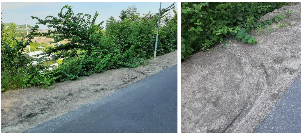
Figur 5. Rinnväg vid punkt 2 i Figur 3 (från platsbesök 2021-07-13).
