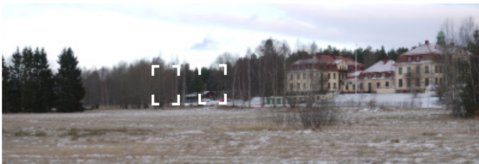
Planområdet sett från Ullebergsleden. Där den röda ladan ligger kommer de nya husen placeras.
