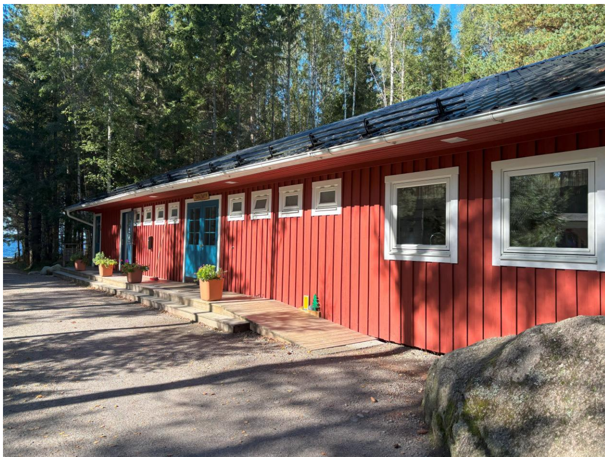
Figur 11: Bild på servicebyggnaden på campingen.
