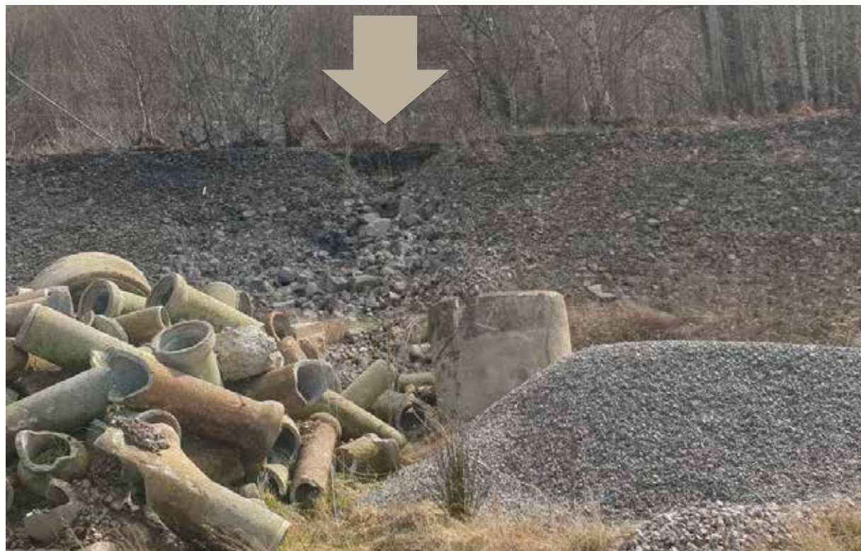
Bildtext: Visar den plats på banvallen där man ser att gruset sköljts bort där trumman har gått sönder (efter åverkan i samband med att Trafikverket anlade en tillfartsväg)
