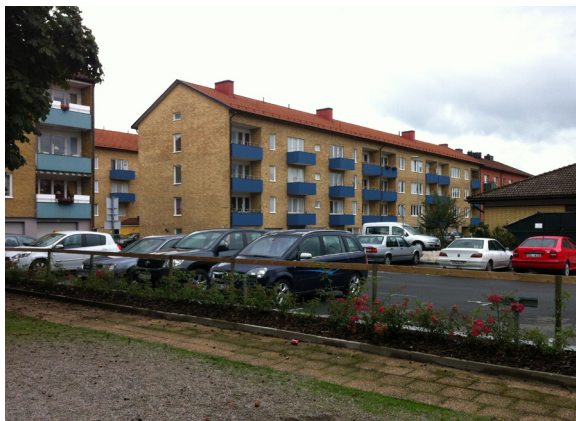
Befintlig parkeringsplats söder om planområdet
