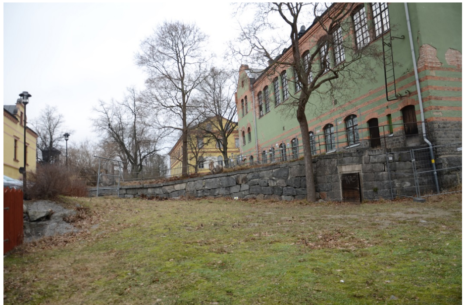
Gymnastikhuset med stenmur som delar upp planområdet i en övre och en lägre del.
