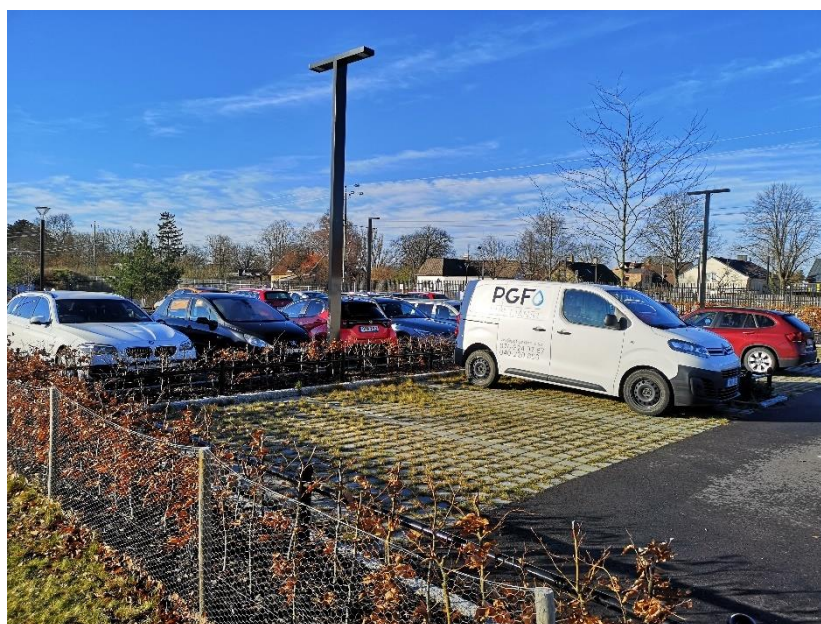
Figur 33: Genomsläpplig beläggning på Lomma station.
