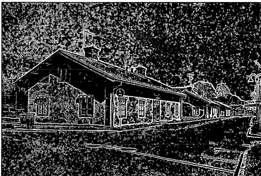
Planområdets envåningshus sedda från Stationsgatan och Resecentrum
