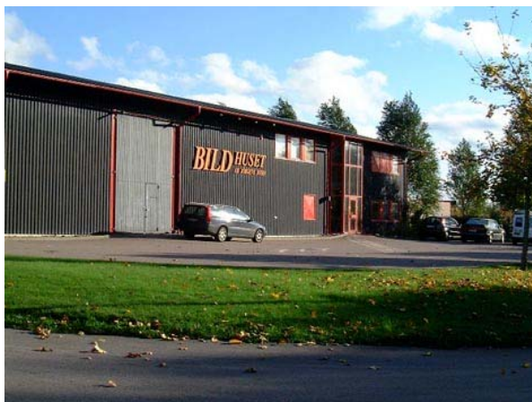
Bildhuset, Söndrums företagspark. Dämpad och varierande färgskala med en tydlig entré. Takutsprång och sparsmakad skyltning, enskilda bokstäver fästa på fasad.
