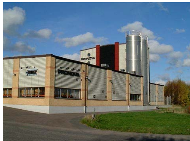
Pronova, Söndrums företagspark. Stor byggnad som volymmässigt brutits ned i olika delar. Varierande fasadmateriell och färgsättning ger ett intressant och genomarbetat intryck. Skyltning med enskilda bokstäver på fasad.
