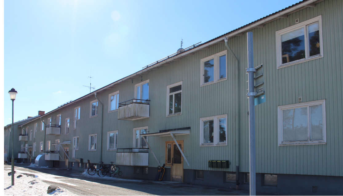
Foto från norr. Sjuksköterskehemmets östra fasad
