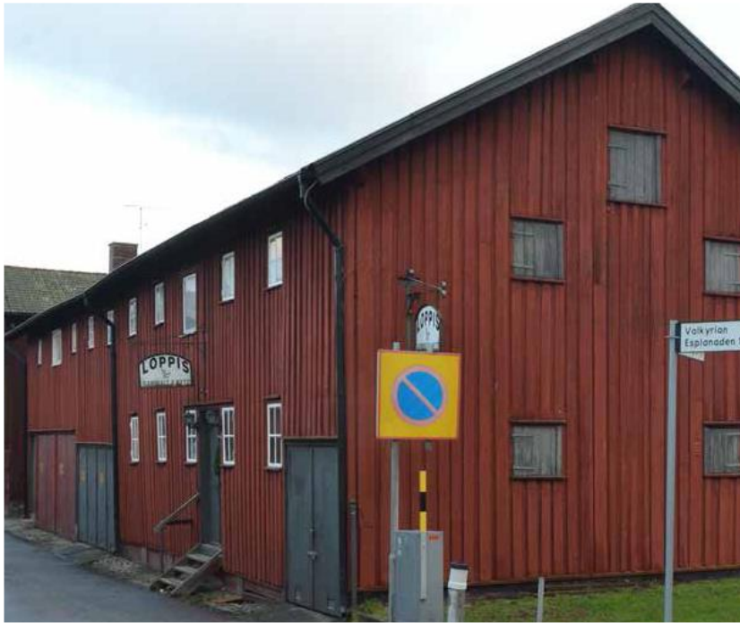
Magasinsbyggnad, fasad mot Särnmarksgatan-Esplanaden
