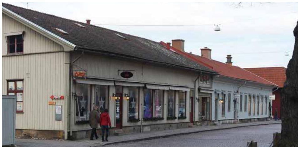
Byggnadens exteriör mot Mellbygatan skyddas i planförslaget.
