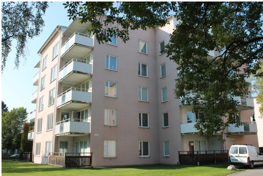
Omgivande bebyggelse: Ett av fem punkthus på kvarteret Falken, motsatt sida om Fabriksgatan.
