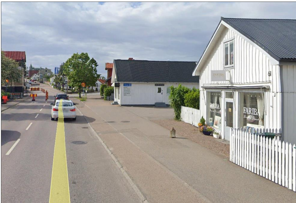
Figur 2 Lågpunkt med dagvattenbrunnar i Köpmansgatan mitt för fastigheten Båtsmannen 5 (Google, 2020)
