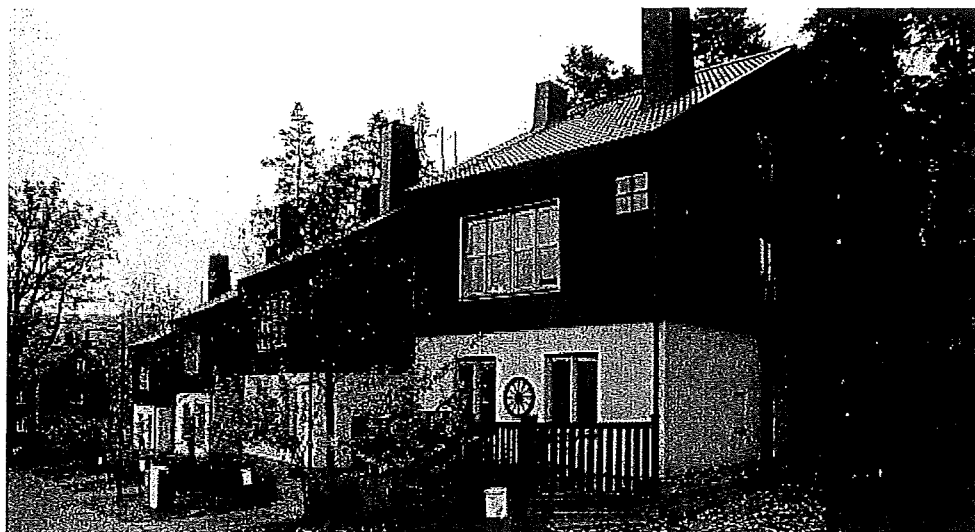
Exempel på sutteräng, Tullinge, med sedumtak på garage
