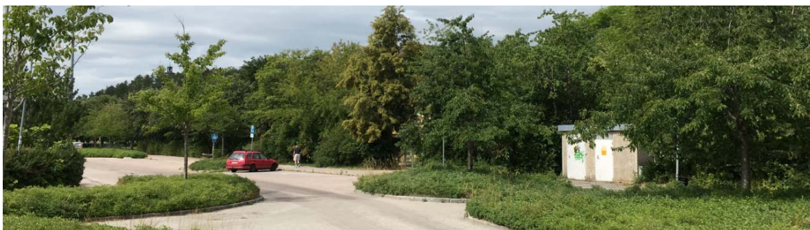
Transformatorstationen vid korsningen med Rotgatan. Befintlig förskola skymtar fram i gult.
