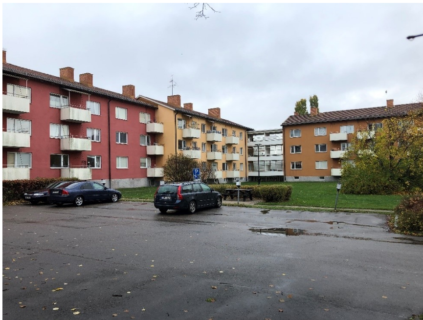
Figur 7. flerfamiljshusen och innergården med grönyta och parkering inom Tulpanen 11.
