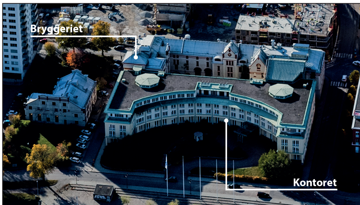
Bild: Befintliga byggnader inom Pyramiden 20
