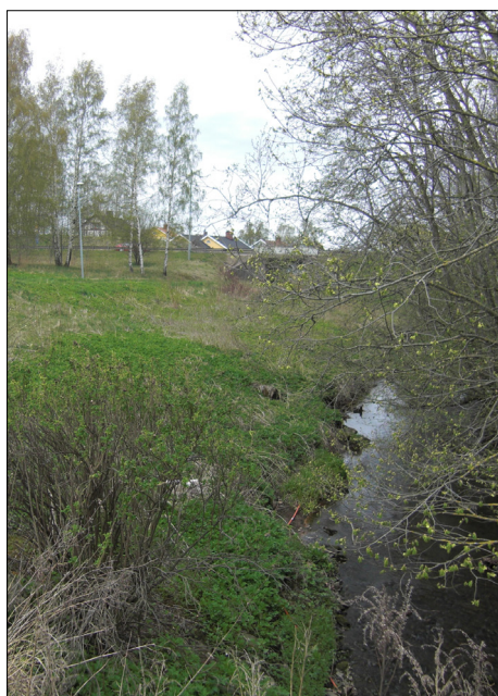
Befintligt öppet dike mellan väg 26 och Norra Aspelundsvägen
