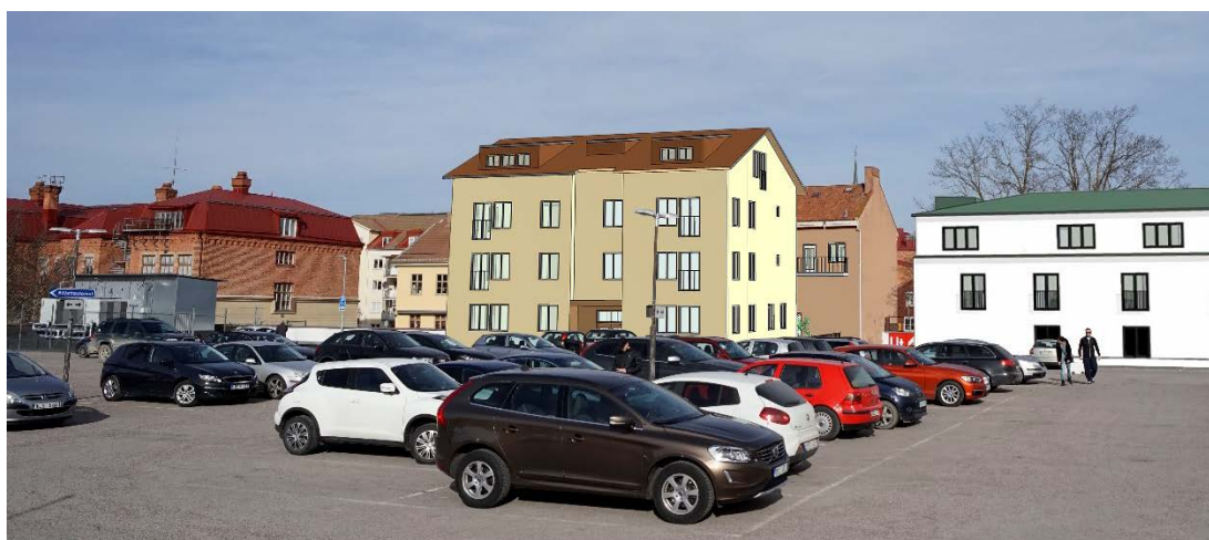
Figur 7. Vy från Åhlénstaket. Hotellet under uppförande syns till höger. (Carlstedt Arkitekter).
