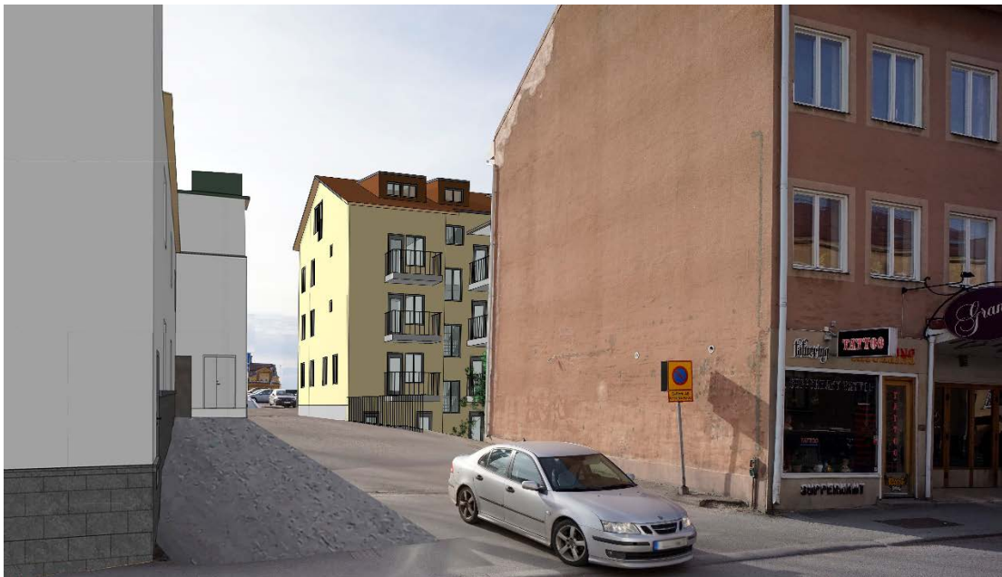
Figur 9. Vy från Brunnsgatan upp längs rampen mot parkeringen på Åhlénstaket. Hotellet under uppförande syns till vänster. (Carlstedt Arkitekter).
