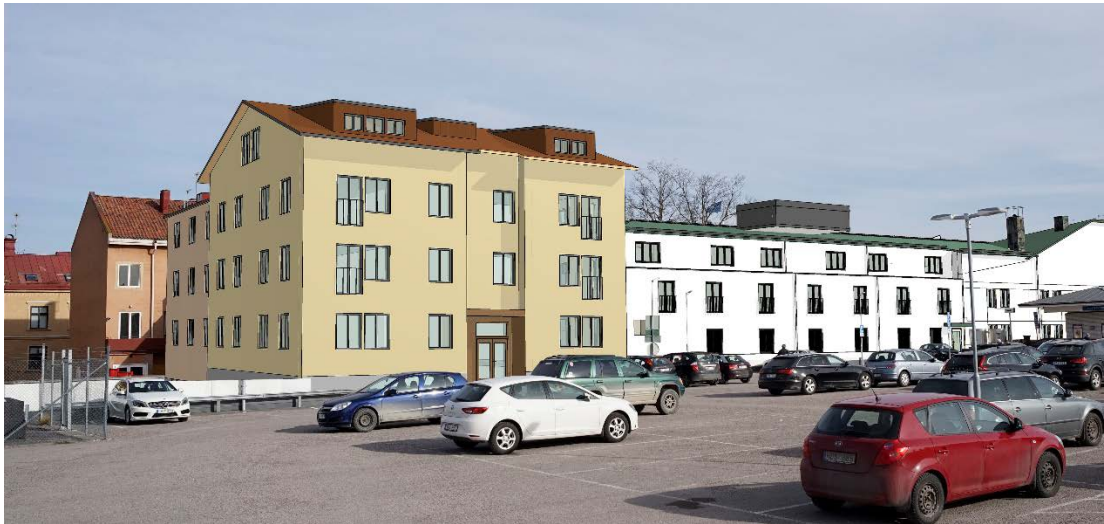
Figur 8. Vy från Åhlénstaket. Hotellet under uppförande syns till höger. (Carlstedt Arkitekter).
