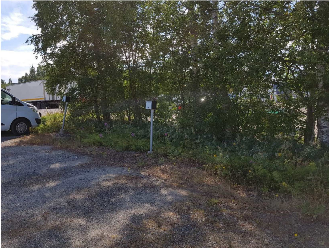
Figur 6 Dike mellan fastigheterna Högland 7:15 och Kronan 1.
