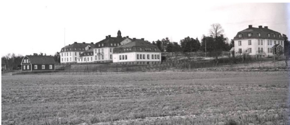
Bild från den antikvariska förundersökningen (Värmlands museum). Till höger syns "arbetshemmet"
