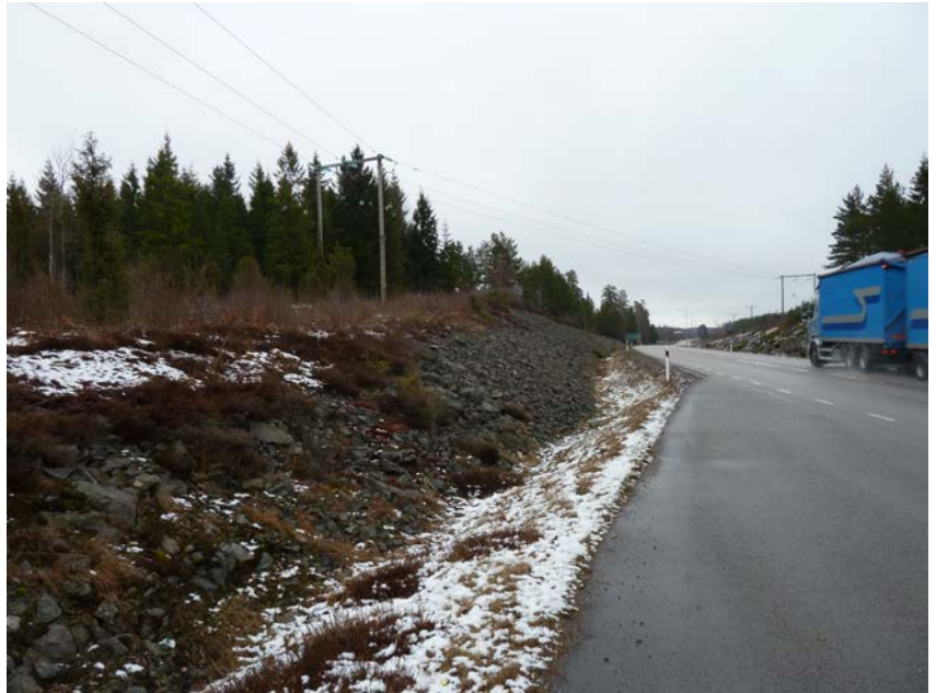
Bild som visar riksväg 23.
