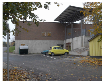
Befintligt varuintag och transformatorstation
