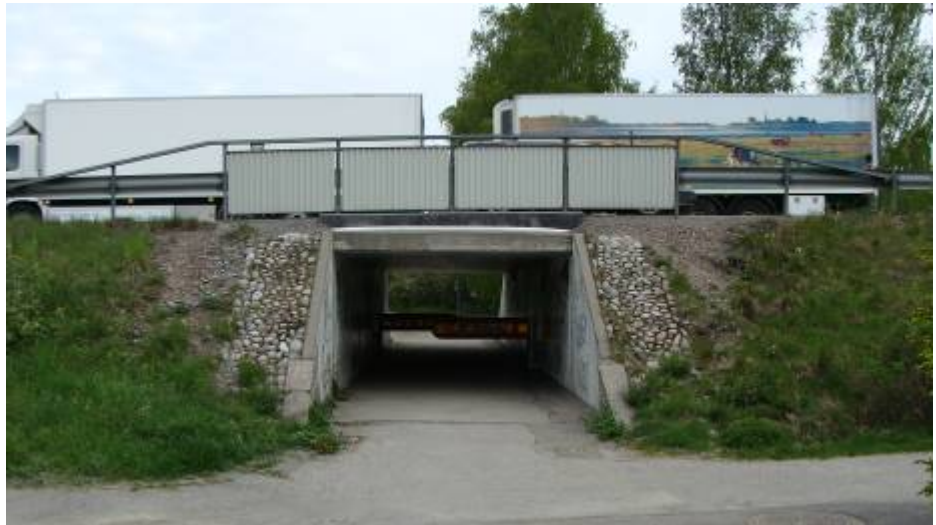
Bild på gång- och cykeltunneln under E18.
