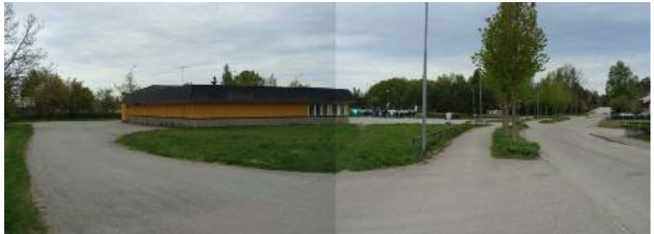
Bild tagen mot sydväst (mot E18)
