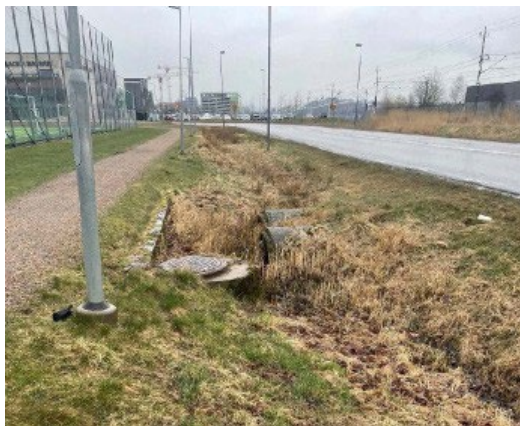
Dagvattentrumma längs Södra infarten.
