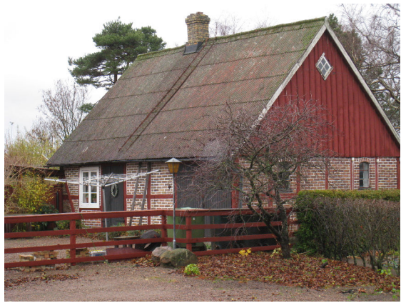
Tunneberga 3:9 uthus k2, q
