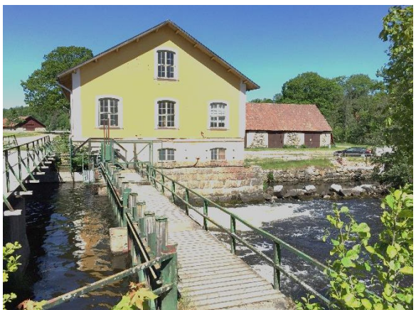
Gamla kraftverket från 1899
