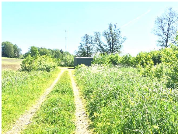
Grusväg vid Forssjön och pumpstation för reservvatten
