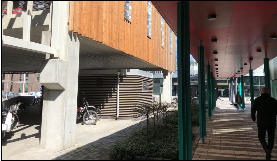
Nätstation som en integrerad del av ett parkeringshus
