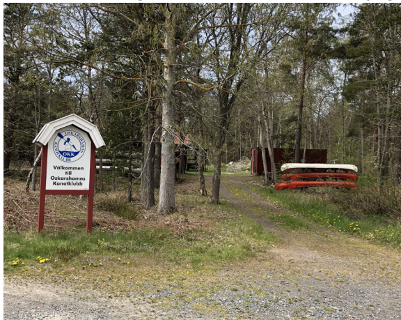
Bilden visar den befintliga infarten till kanotklubben från parkeringsplatsen.
