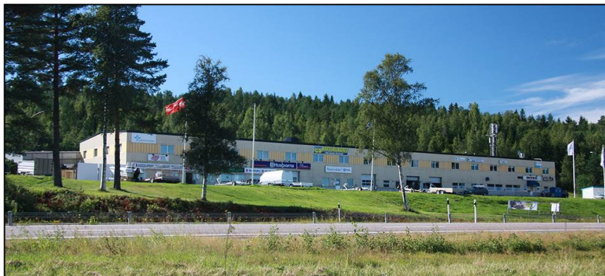
Befintligt utseende på den västra byggnaden. Bilden är tagen från E4 (mot söder). Källa: Örnsköldsviks kommun.
