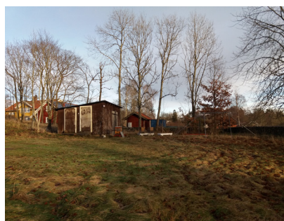
Befintlig komplementbyggnad i öst, fasad mot väster
