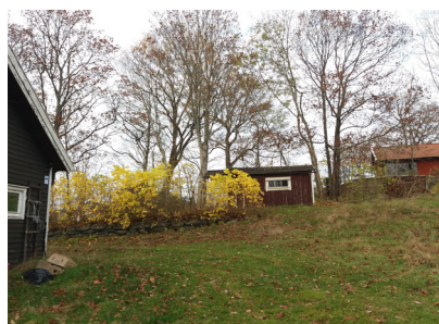
Befintlig komplementbyggnad i norr, fasad mot söder
