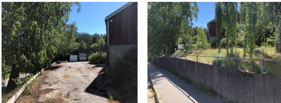
Figur 6 – Vänstra bilden: fastigheten Späckhuggaren 1 västerifrån. Bilden visar byggnadens baksida. Vänster i bild skimras Båtsmannabacken. Högra bilden: fastigheten Späckhuggaren 1 från Båtsmannabacken. Bilden visar höjdskillnaden och stödmuren mellan fastigheten och Båtsmannabacken.
