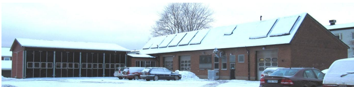
"Byggnad 4" och "5", garage och verkstad
