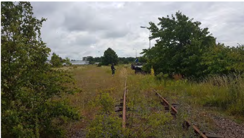
Del av befintligt spårområde som skall avvecklas
