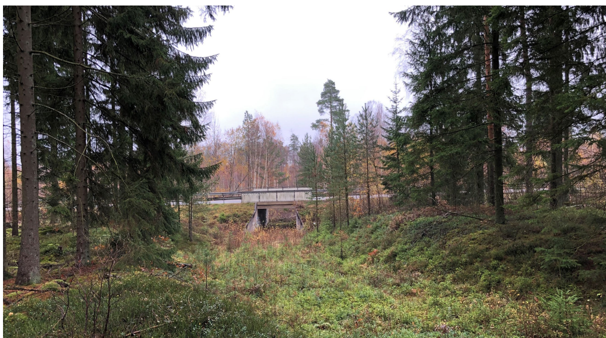
Bild 26. Befintlig tunnel under Danska vägen.
