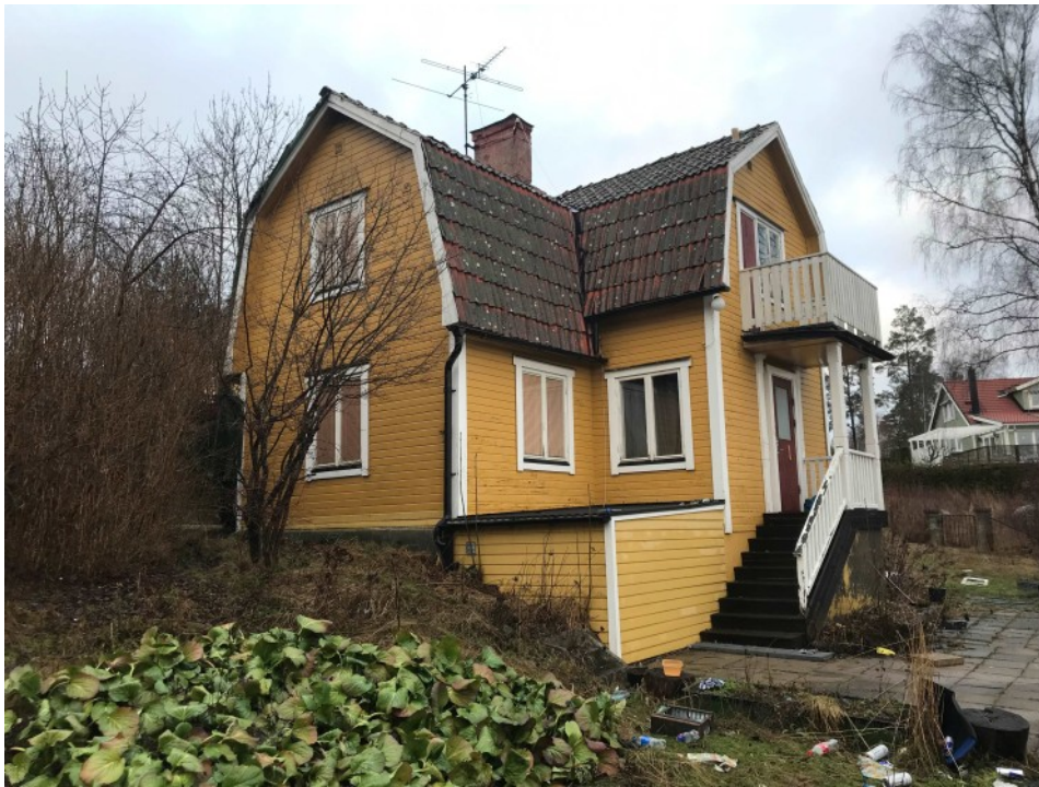
Befintlig huvudbyggnad på Norrbacka 6:5
