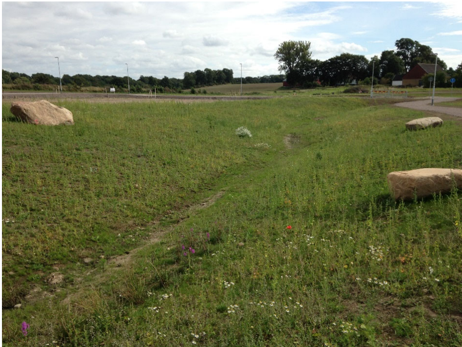
Dagvattenstråk i sydöstra Gantofta när det var nyanlagt. Foto: Sofia Augustsson NSVA
