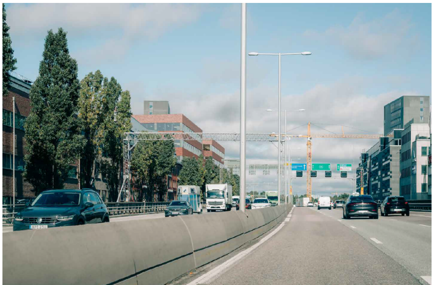
Påbyggnaden sedd söderifrån från Essingeleden, bild Wingårdhs.
