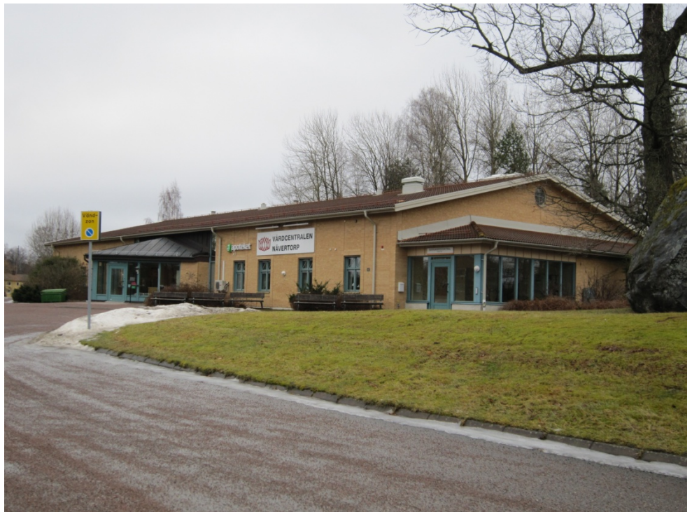
Vårdcentralen norr om planområdet
