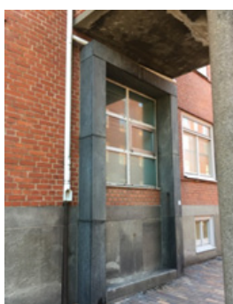
Ursprunglig port mot Selma Lagerlöfs väg som ersatts av fönster och mur.
