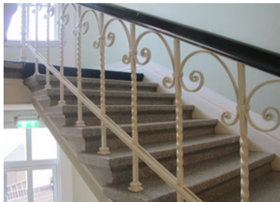
Trappa i terrazzo med smitt räcke och handledare i trä.
