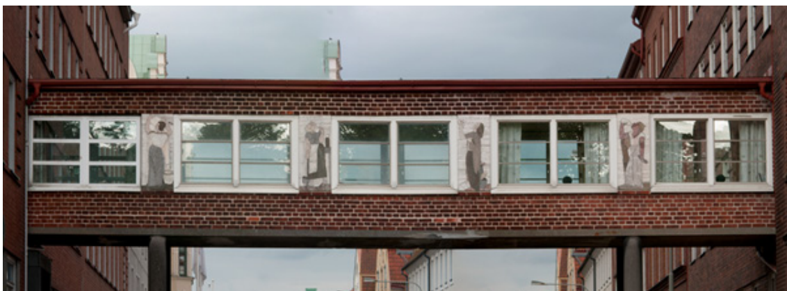
Förbindelsegång över Selma Lagerlöfs väg. Vy från väster.
