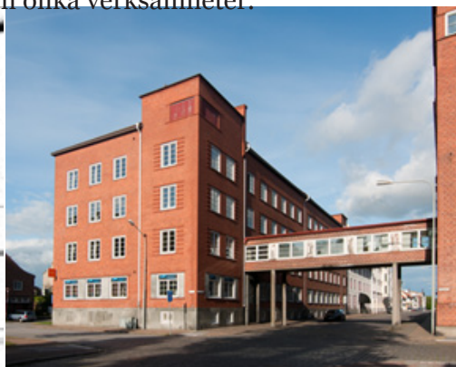
Sylvahuset, vy från väster längs Selma Lagerlöfs väg.
