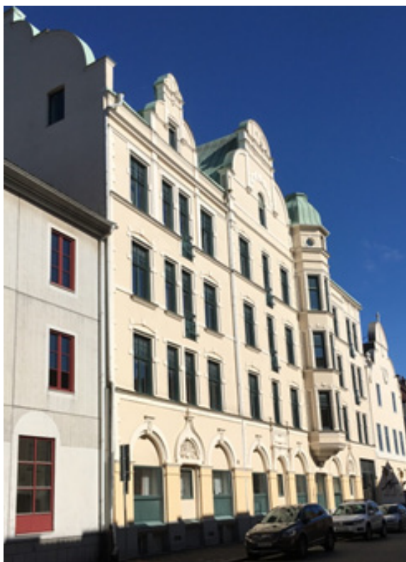
Fasad mot Selma Lagerlöfs väg.
