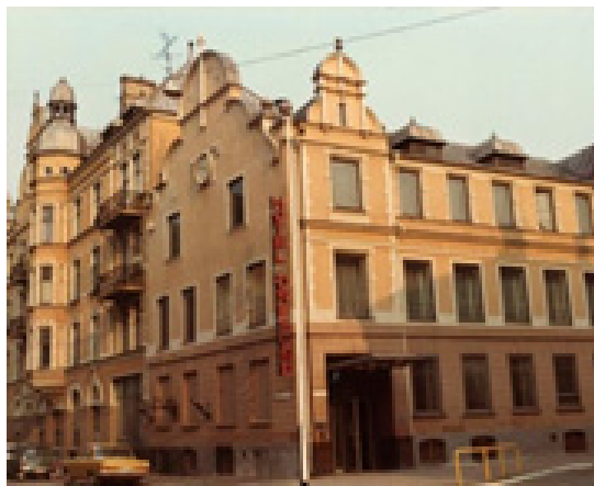
Hotell Öresund på 70-talet, med entré mot Kungsgatan.
