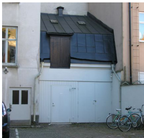
Byggnad K (gårdshuset).
