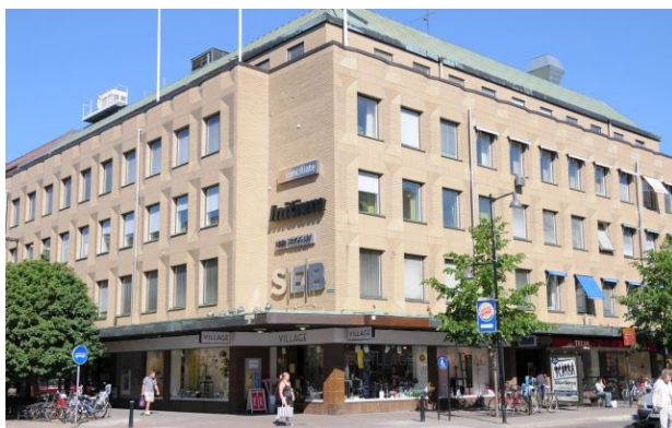
Byggnad G, korsning Drottninggatan/Järnvägsgatan.
