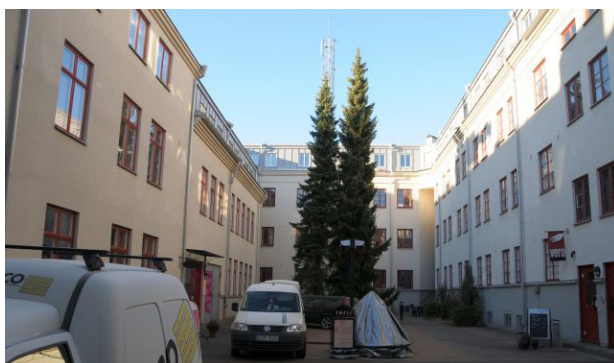
Byggnad E och F samt innergård.
