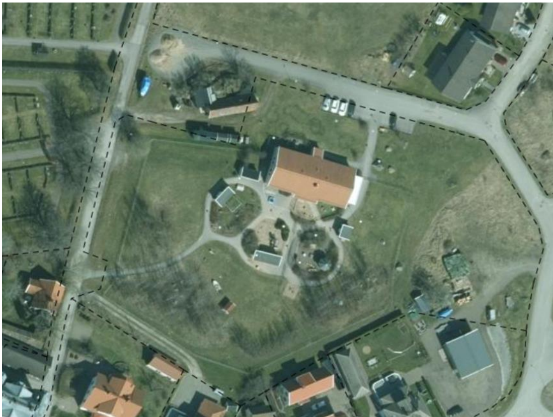
Figur 6 Ortofoto över byggnationen på fastigheten Flarka 5:59
