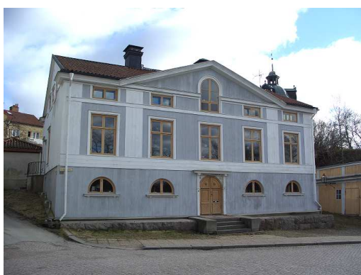
Fasad mot Östra Kyrkogården efter renoveringen.
