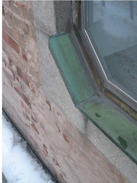
Detalj av mur och fönster. Fönstrets avfasade hörn är tidstypiska för 1950-talet.
