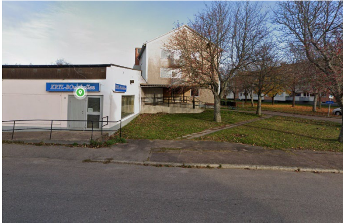
Södra delen av området sett från Västerbovägen. Boulhallen t.v. T.h. entré med ramp, tilltänkt ingång till blivande skolan.
