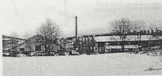
Fabriksområdet sett från söder.
