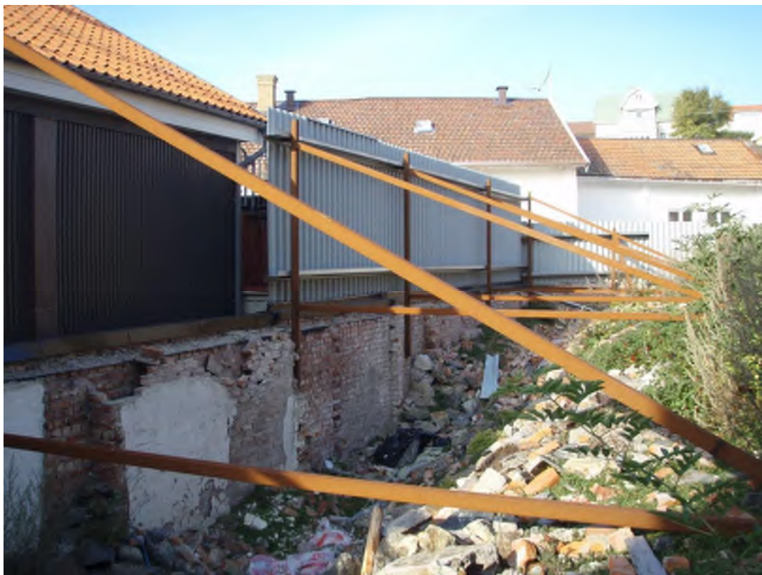
Befintlig brandmur och tillfälliga brandskärmar.
