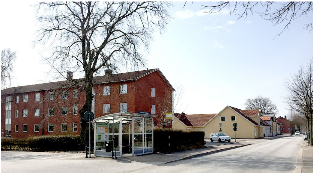
Trevåningsbebyggelse i kvarteret söder om Kungsgatan mellan planområdet och järnvägen.
