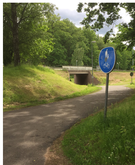
Befintlig gång- och cykeltunnel under Kavelbrovägen
