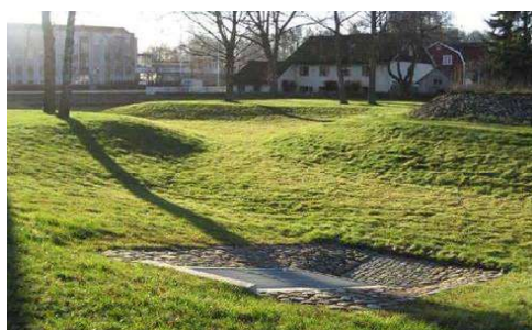
Bild till vänster visar exempel på Torrdamm
